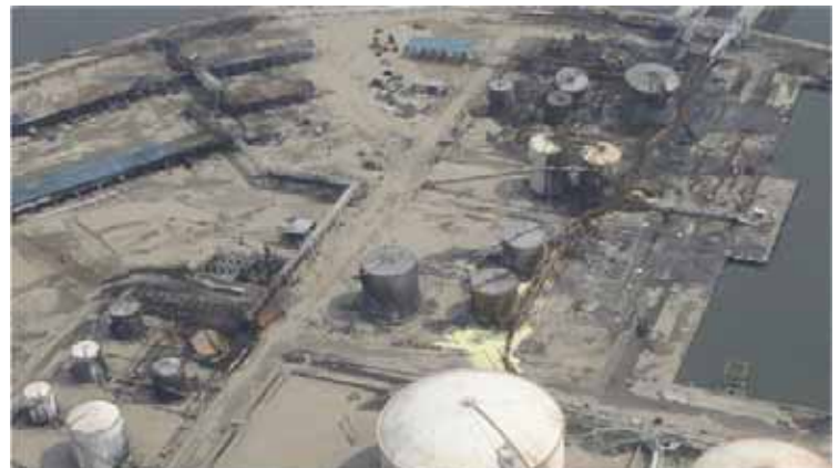
津波により火災が発生した製油所の状況(宮城県多賀城市) (平成23年3月30日11時頃撮影) (塩釜地区消防事務組合消防本部提供)
