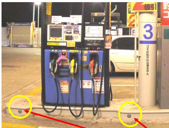
アイランドに泡ノズルが埋込まれており、横から水平方向に扇型で機械泡消火薬剤が放射されます
