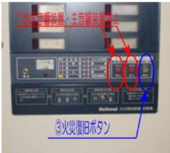
平成 9 年の消防法施行規則改正前の受信機は、左写真のように、『地区音響停止釦』と記載され、定位と停止位置表示をされており、停止にスイッチを切り替えるとずっと停止してしまうタイプでした。このタイプの受信機ですと、火災発報の時に、とりあえずうるさいので地区音響を停止されてしまうと、再度、定位に戻さない限りベルは鳴動しません。ベル停止・解除のルールを再確認をお願いします。
